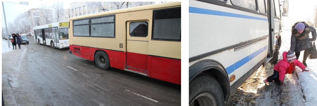
Рис. 2 Образование снежного наката на остановочных пунктах
