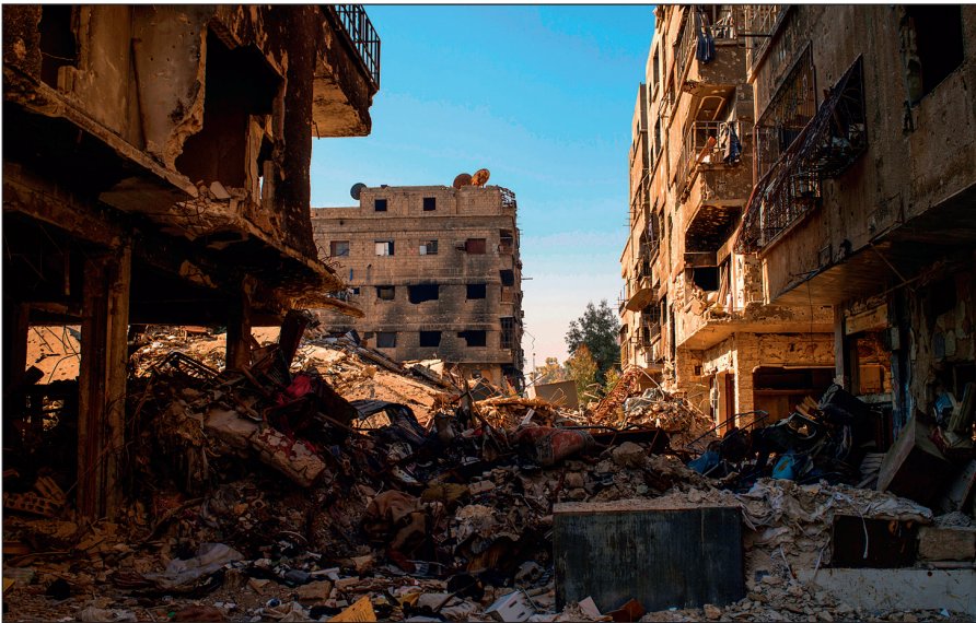
Разрушенный боевиками ИГИЛ Дамаск.
