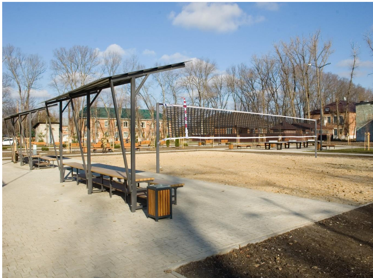
Устройство площадки для пляжного волейбола
