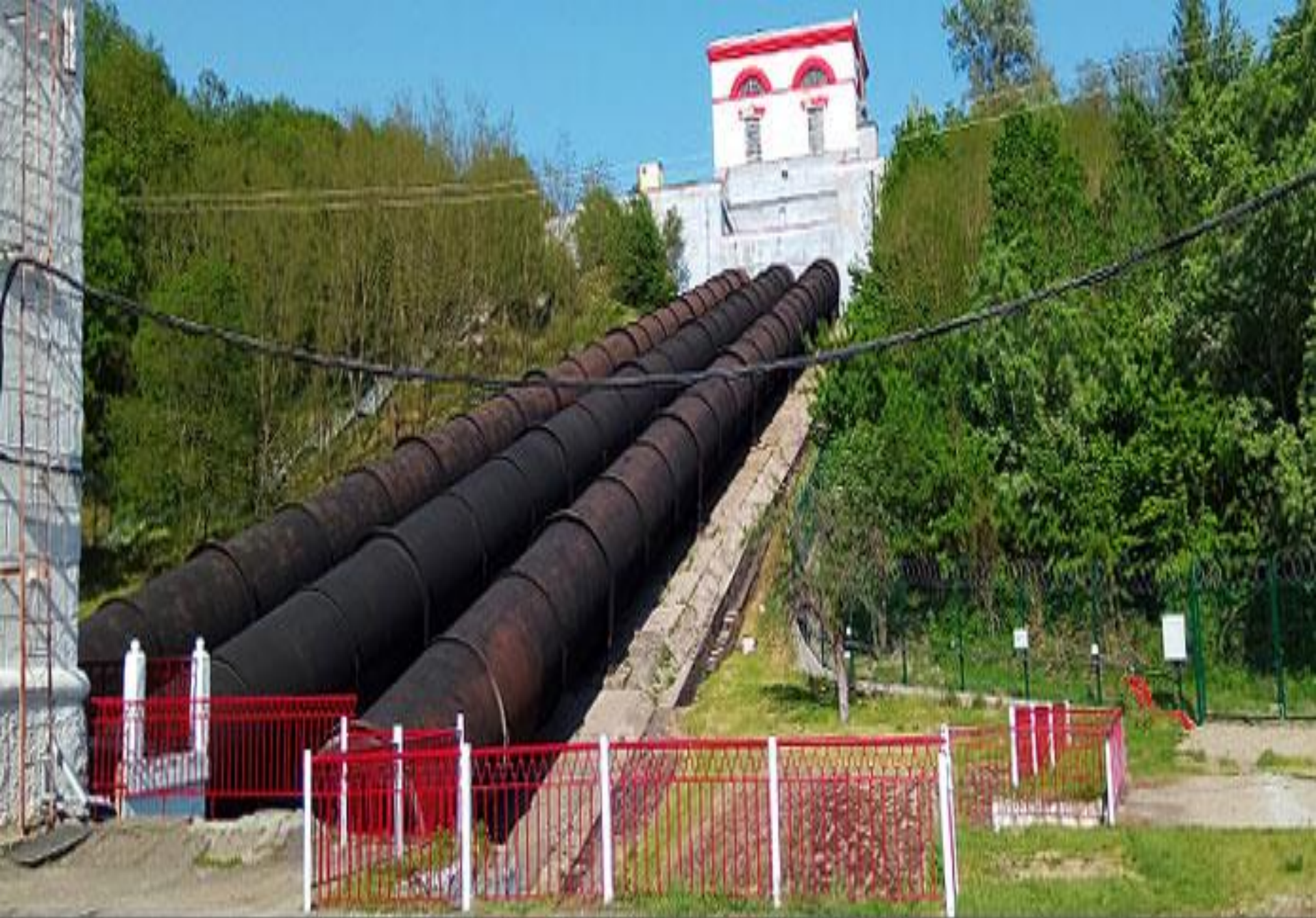
Напорные водоводы Белореченской ГЭС. Фото сделано во время 3D сканирования тракта гидроагрегата
