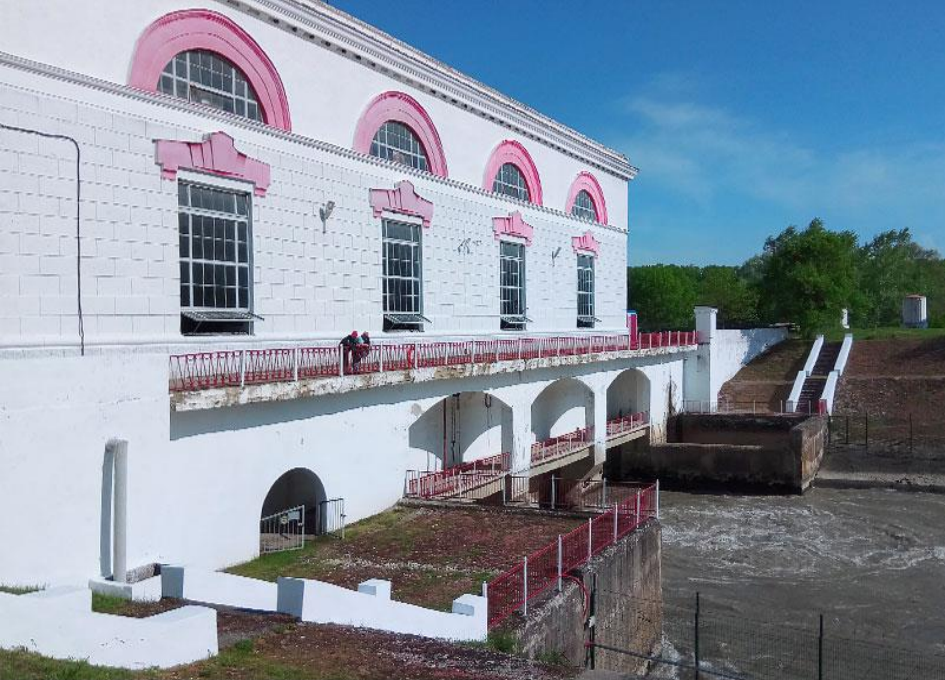
Здание Белореченской ГЭС во время проведения на ней лазерного сканирования водоотводящего тракта гидроагрегата
