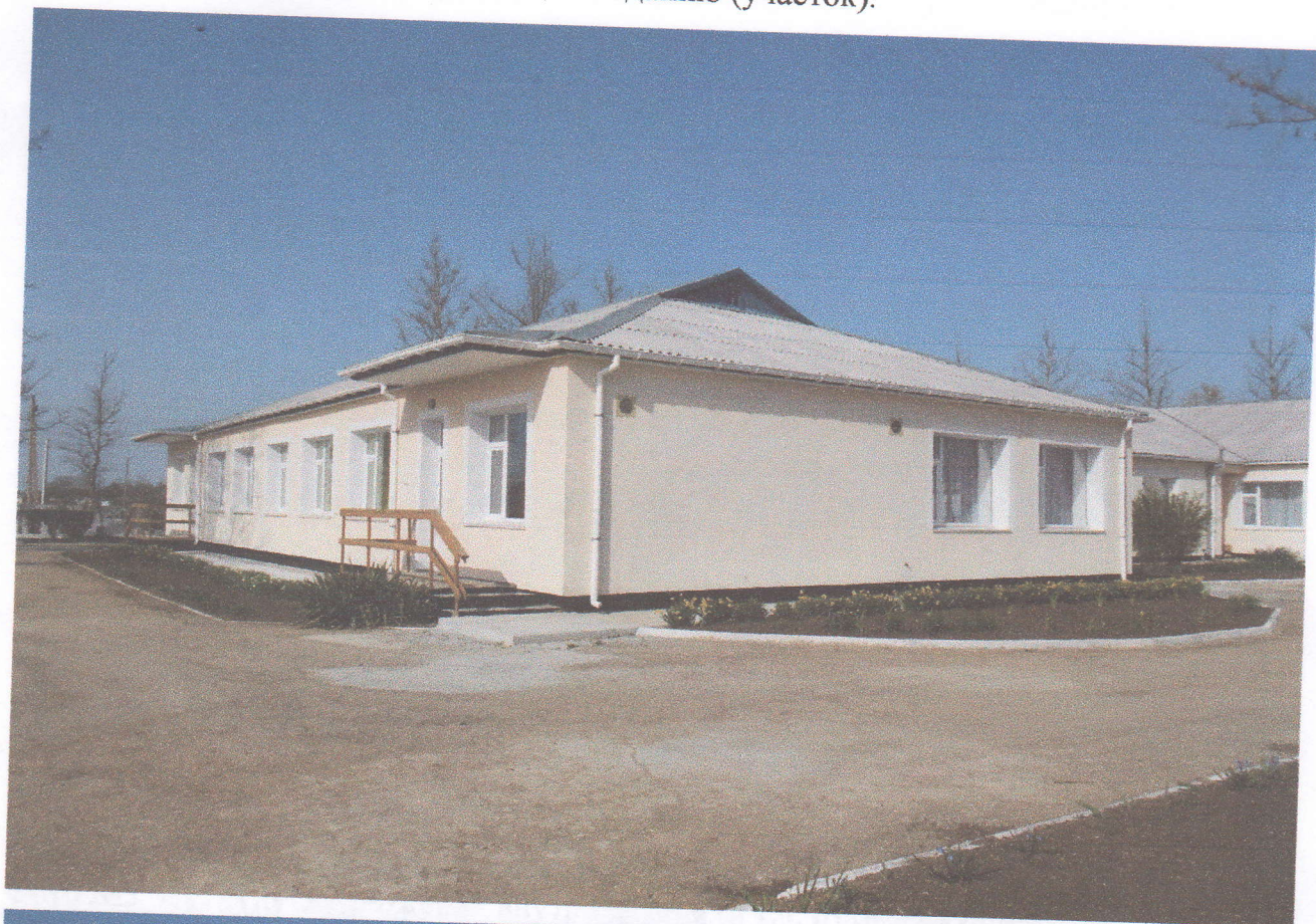
Фото №1. Территория, прилегающая к зданию (участок).
