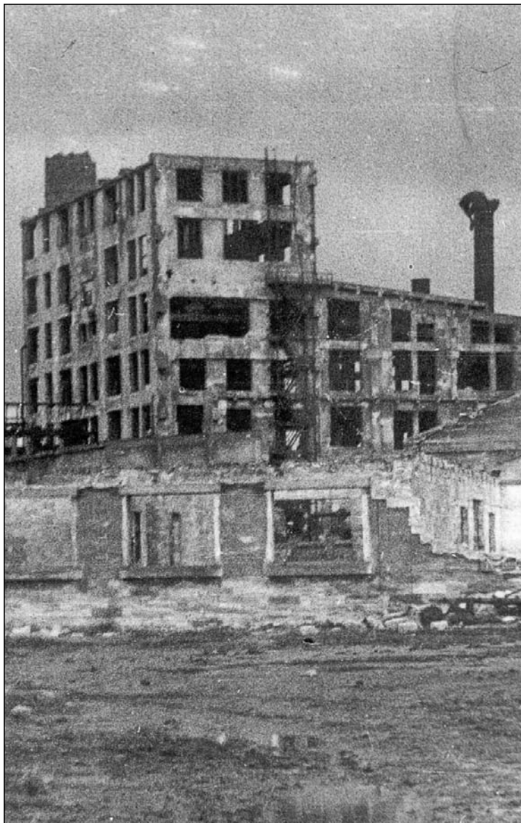
Разрушенные сооружения одного из цехов завода им. Войкова, г. Керчь
