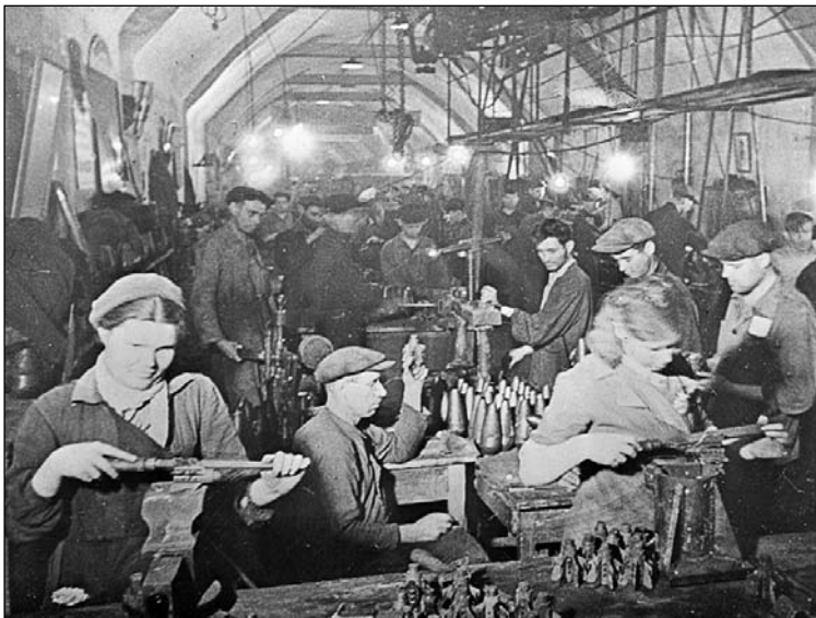
Один из производственных цехов Севастопольского подземного военного спецкомбината №1
