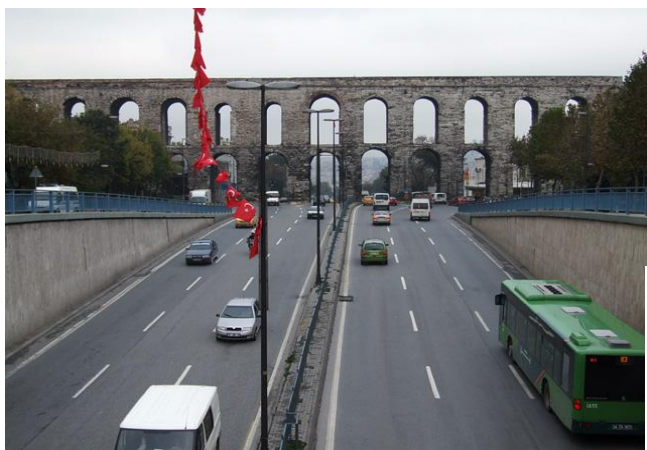
Дорога с акведуком
