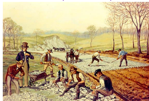
Строительство дороги Мак-Адамом
