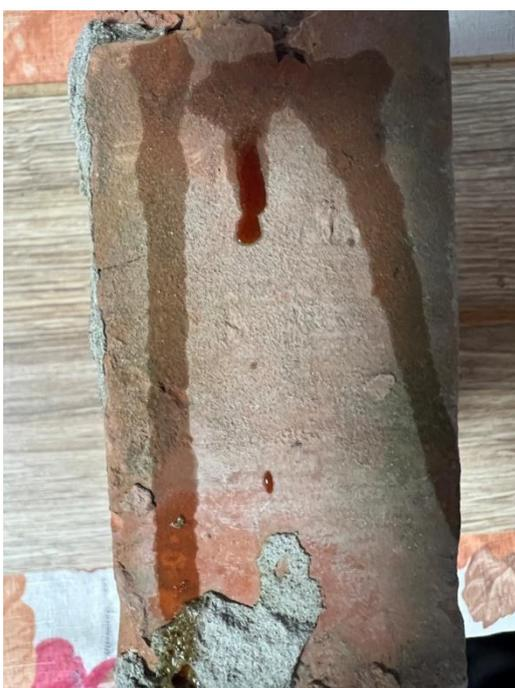
Рисунок3 Образование потеков на кирпичной поверхности
