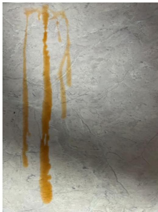
Рисунок 4 Образование потеков на поверхности керамической плитки
