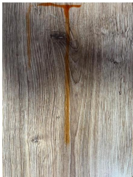
Рисунок 2 Образование потеков на деревянной поверхности
