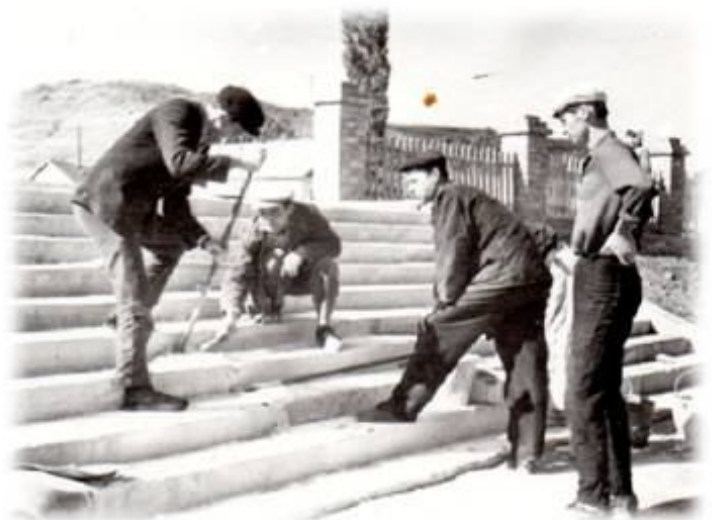
Строительство новой школы
