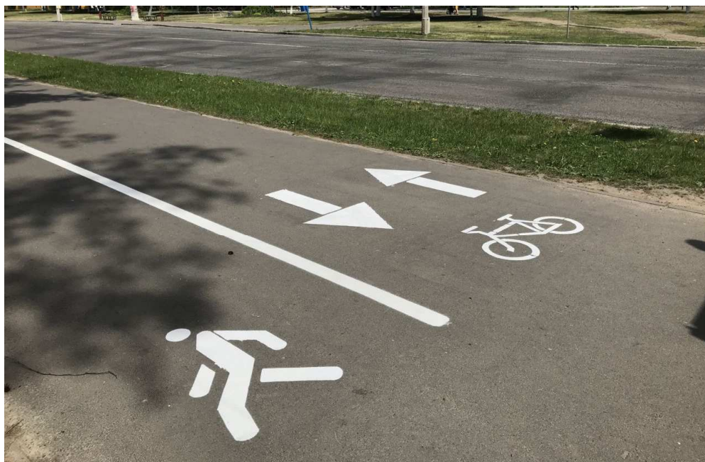
Рисунок 4 Пример разделения велосипедного и пешеходного потоков
