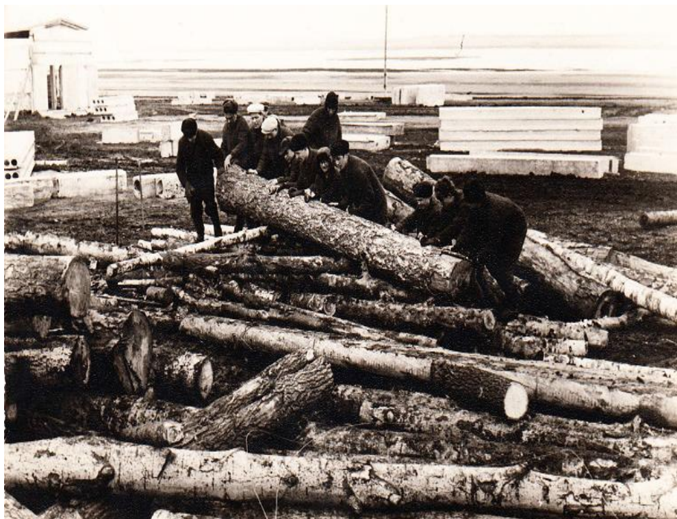
Работники училища на строительстве учебного корпуса.
