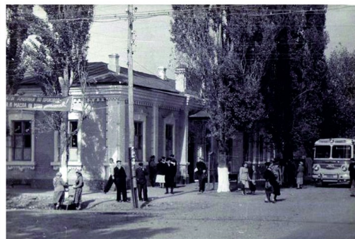
Здание заезжего двора (гостиницы) купца Оникова, 1907 г. постройки (ул. Красная, 65)
