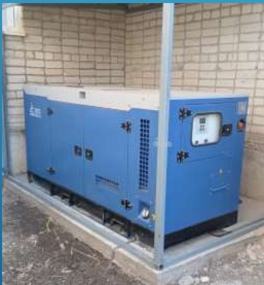
Установка резервного источника питания д/с № 18
