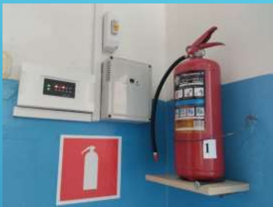
Установка автоматической пожарной сигнализации и системы оповещения д/с № 13
