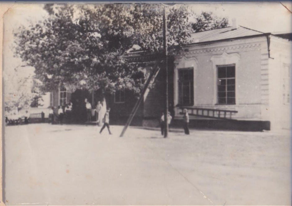
ЗДАНИЕ ШКОЛЫ №8 В СТ. СТАРОМИНСКОЙ, В КОТОРОМ РАЗМЕЩАЛОСЬ ГЕСТАПО, ГДЕ ПЫТАЛИ ПОДПОЛЬЩИКОВ.
