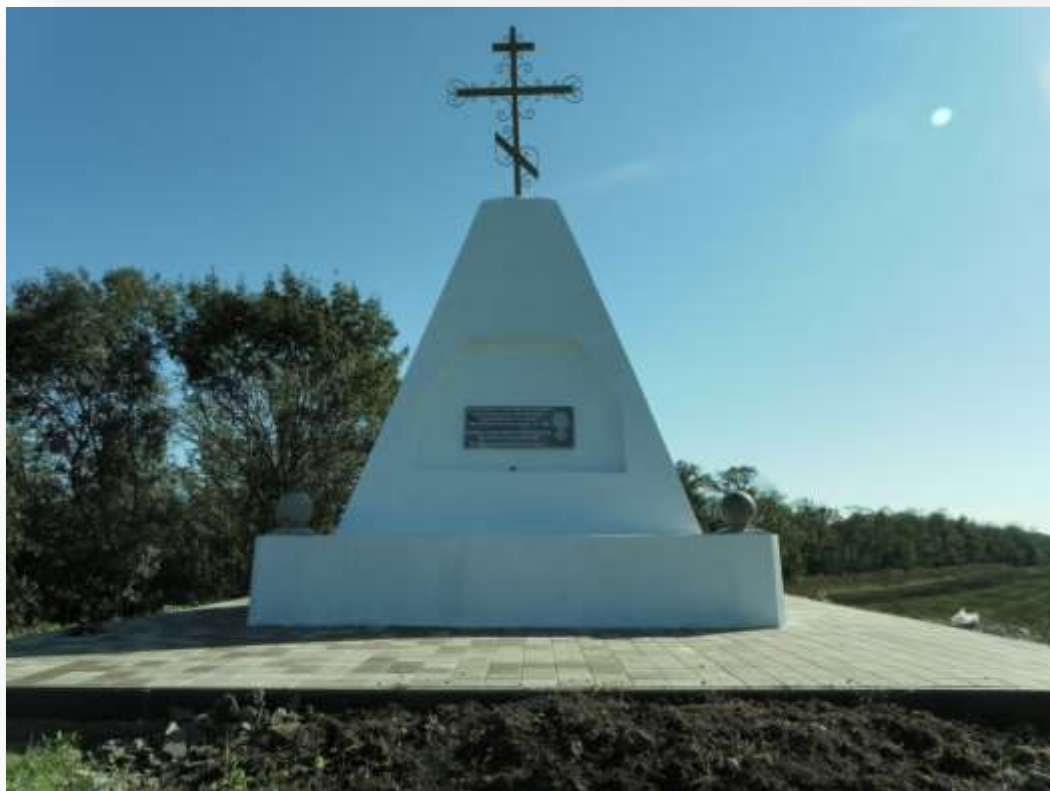
Памятный знак после ремонта
