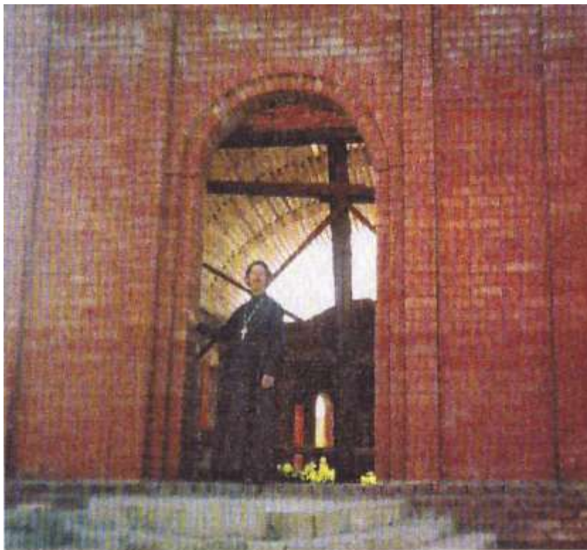
Фрагмент строящегося Свято – Ефремо – Сиринского храма
