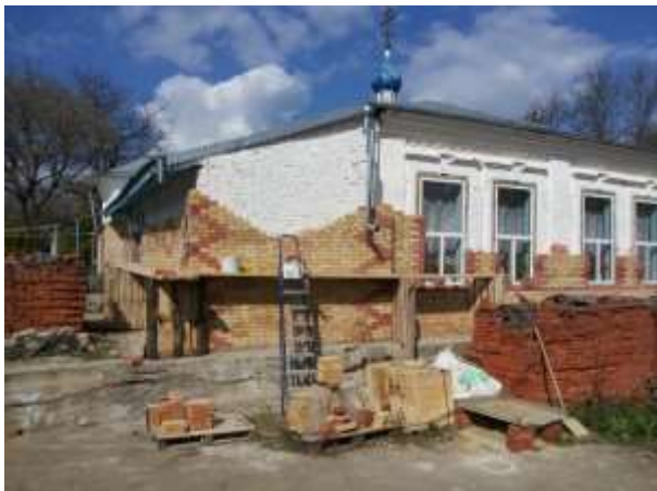
Кладка стен облицовочным кирпичом.
