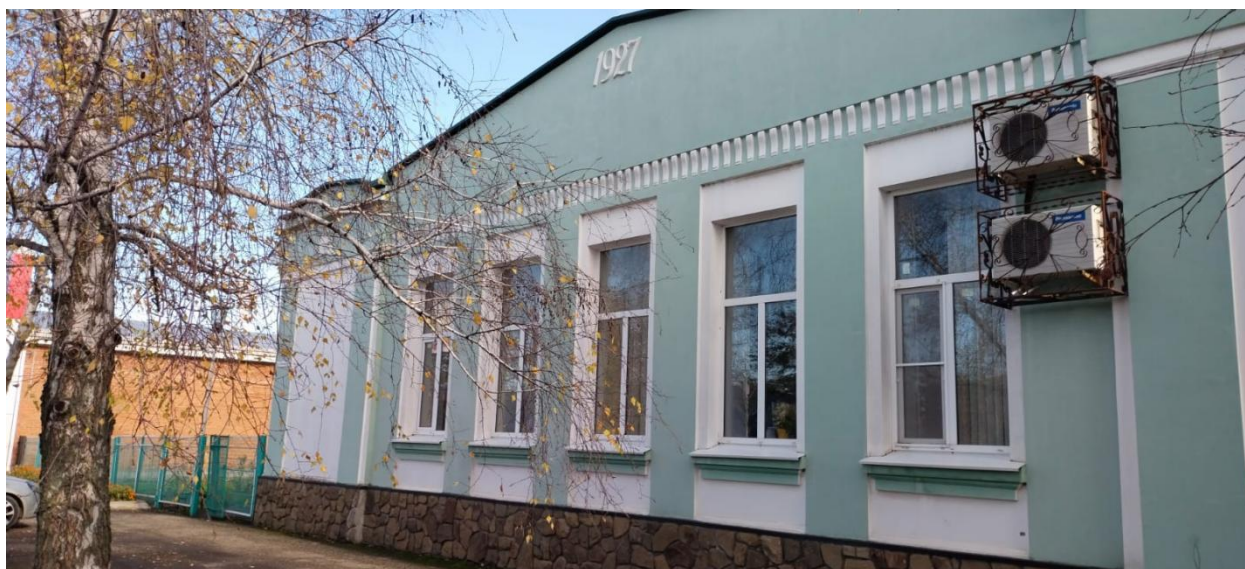
Рис. 4 - Фасадная часть здания в ст. Павловской на ул. Ленина, дом 18, в котором размещается управления Павловского элеватора (ООО «Павловский элеватор») и ООО «Торговая компания «КОЛОС». Фото – Браславец С.Н., ноябрь 2023 г.
