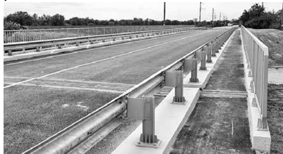
На мосту предусмотрен технологический проход
