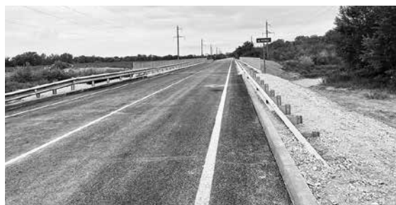
Длина моста – 75 погонных метров, ширина – 12 метров, протяжённость приведённых в порядок подходов к нему – почти 65 метров
