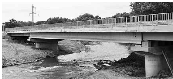
Сложнее всего было установить новые сваи в русле реки
