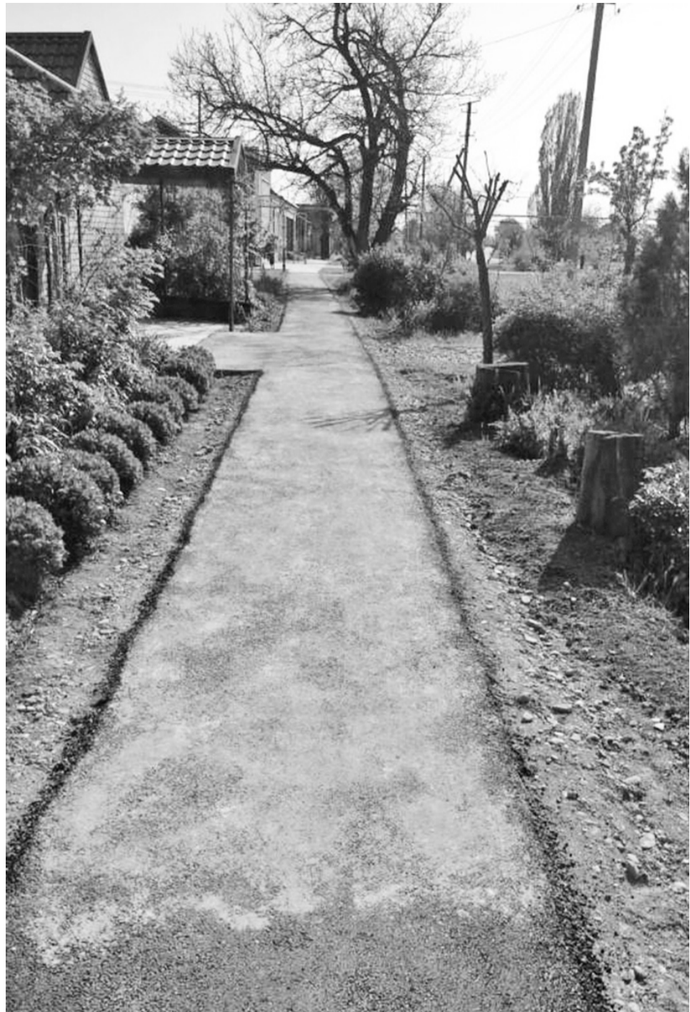
Тротуар по улице Пролетарской в с.Нины
