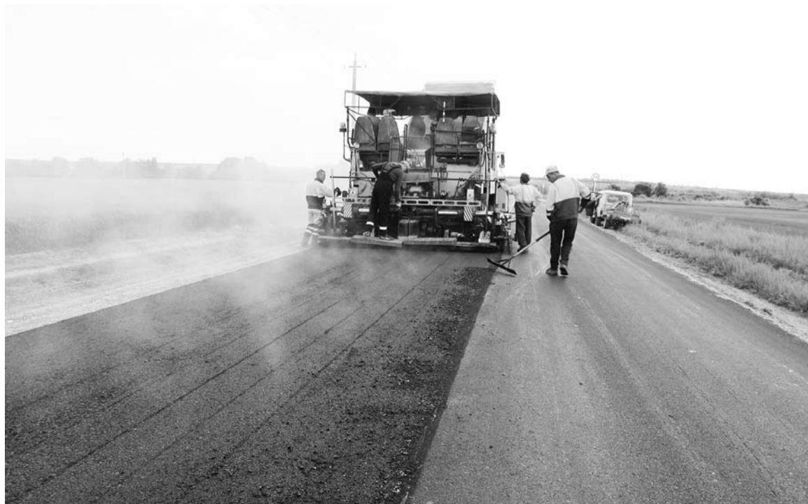
Идёт укладка асфальта...
