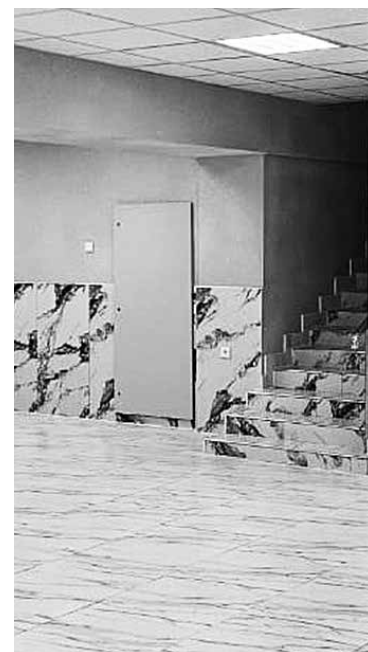
Стеновая отделка и пол внутри здания, его фасад выполнены из керамогранитных плит
