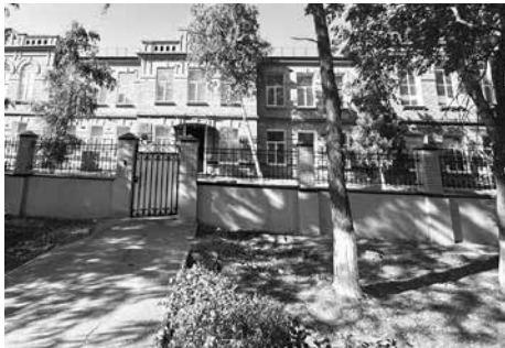
Старейшая школа округа №1 г.Зеленокумск после капитального ремонта
