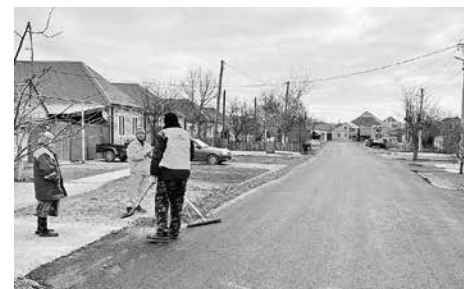
Последние штрихи, завершающие ремонт полотна. / фото: НАТАЛЬЯ МАСЛЕННИКОВА
