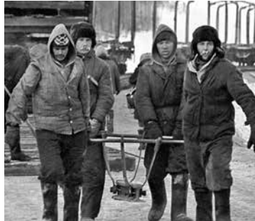
Укладка железной дороги
