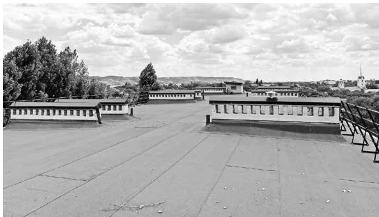
Крыша дома №130 по улице Мира в г.Зеленокумске.
