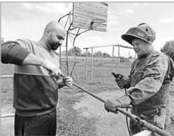
Артур Гукасян и Иван Кузнецов выполняют сварочные работы. / фото: ЛАРИСА КОЗЛОВ-ЦЕВА
