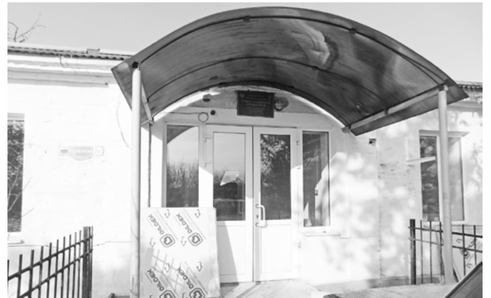
В нынешнем году завершится капитальный ремонт здания амбулатории с.Горькая Балка
