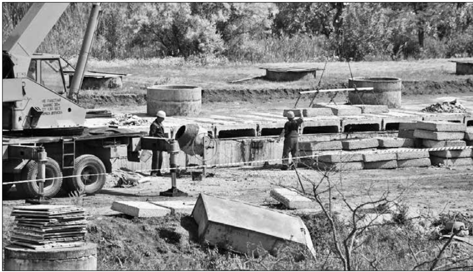
Капитальный ремонт ОСВ в районе с. Курсавка Андроповского округа.
