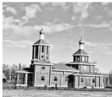
Фундамент храма великомуче- ника Георгия Победоносца в ху- торе Восточном был заложен в 2010 году. Строительство дли- лось 11 лет, первая литургия про- шла в апреле 2021 года.
