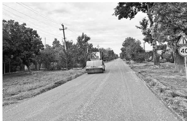
Идёт устройство основания дороги по улице Комсомольской в селе Солдато-Александровском. / ФОТО: НИКИТА ГОЛОСНОЙ
