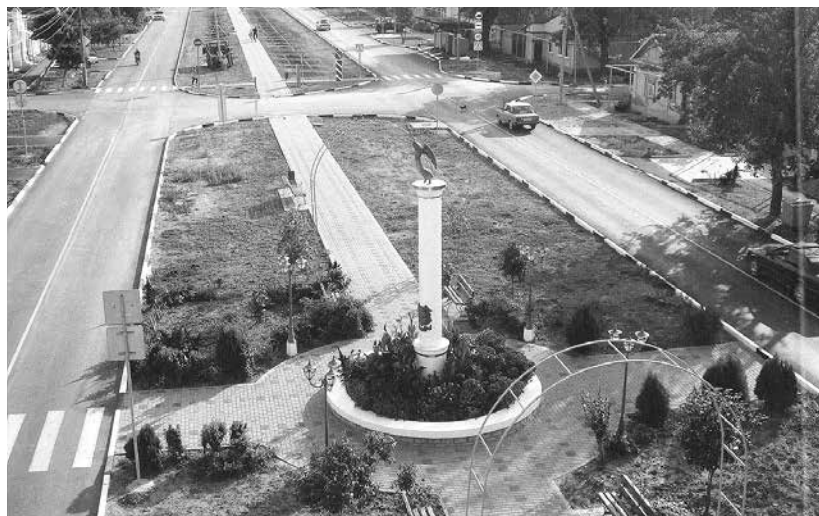
Улица Мира после реконструкции. /фото: АРХИВ «ПНЖ»
