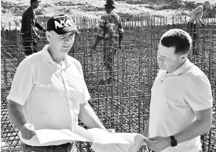
Глава округа Сергей Гулятьев интересуется ходом строительства. / фото: пресс-служба главы округа
