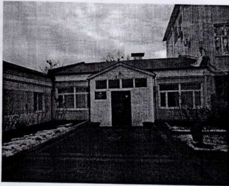
Основной вход в здание
