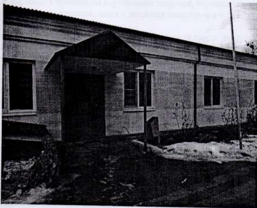
Дополнительный выход из здания.
