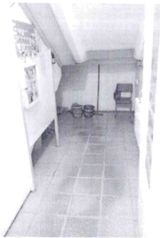
Фото 32. Площадка под лестницей
