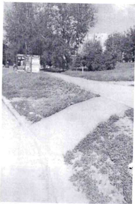
Фото 3. Общий вид на пандус с ул. Лелюшенко
