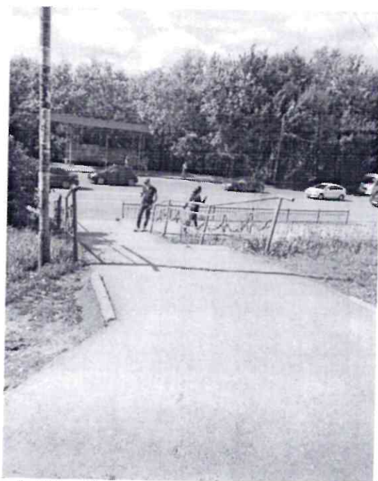
Фото 4. Общий вид на лестницу сверху со стороны тротуара
