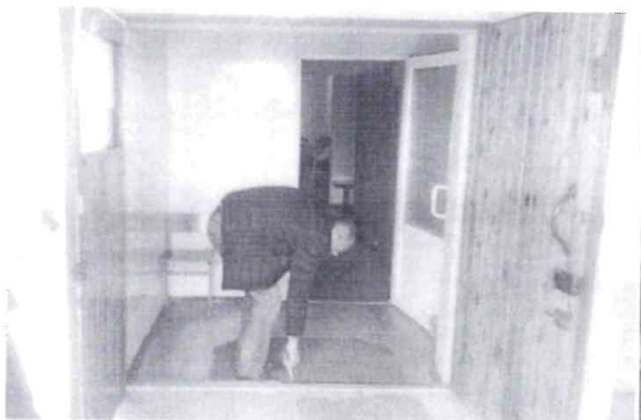
Фото 29. Входная двухстворчатая дверь
