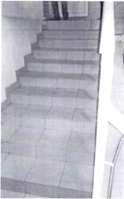
Фото 45. Лестничный марш внутри здания на второй этаж
