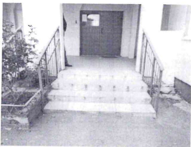
Фото 23. Наружный лестничный марш центрального входа (секция 1)
