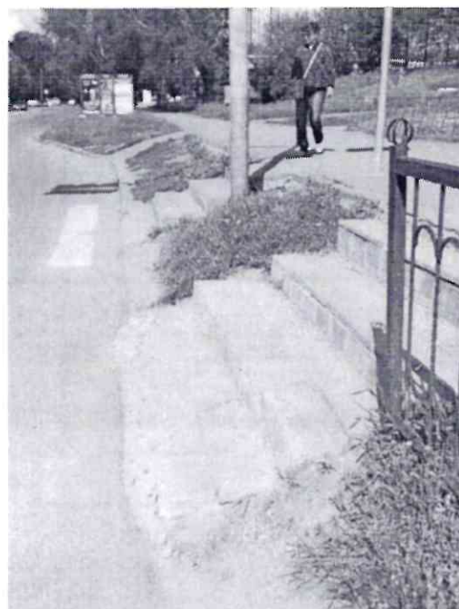
Фото 2. Общий вид на лестницу со стороны остановки по ул. Лелюшенко
