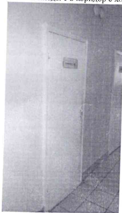
38. Дверь в санузел.
