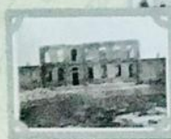
Развалины здания Павловской школы №2 1942-1943 гг.
