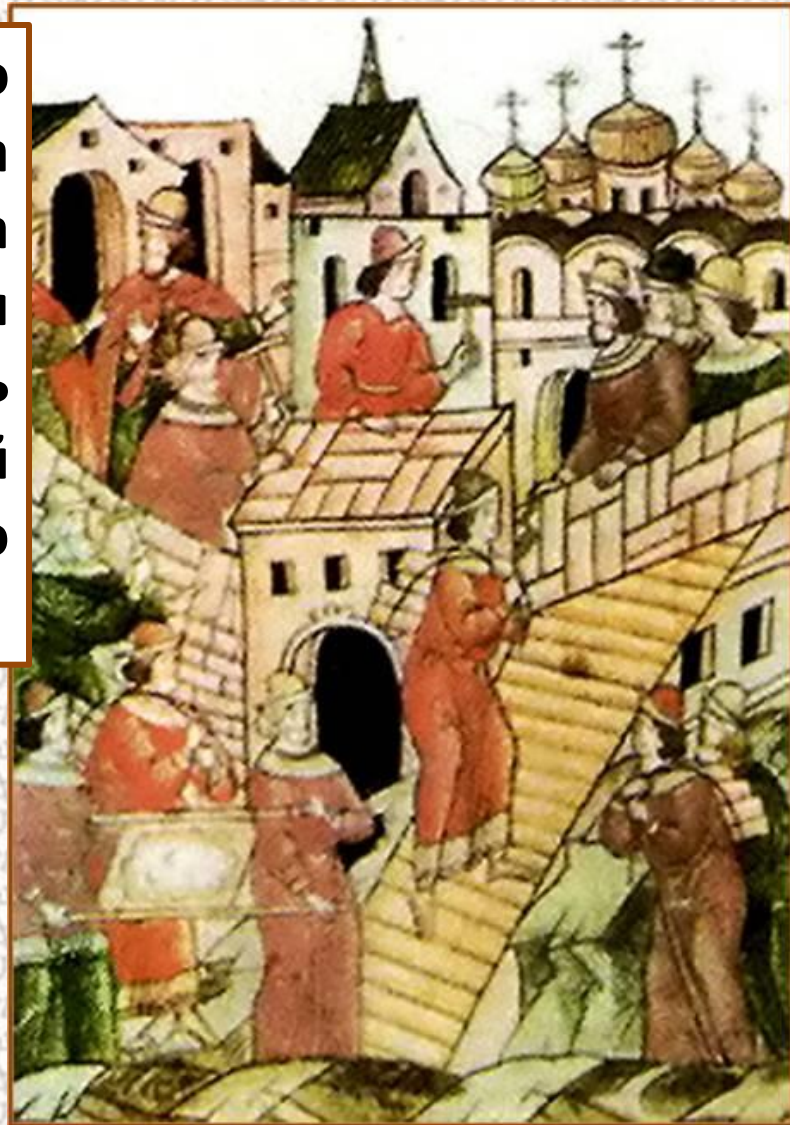
Строительство белокаменного Кремля Летописная миниатюра
