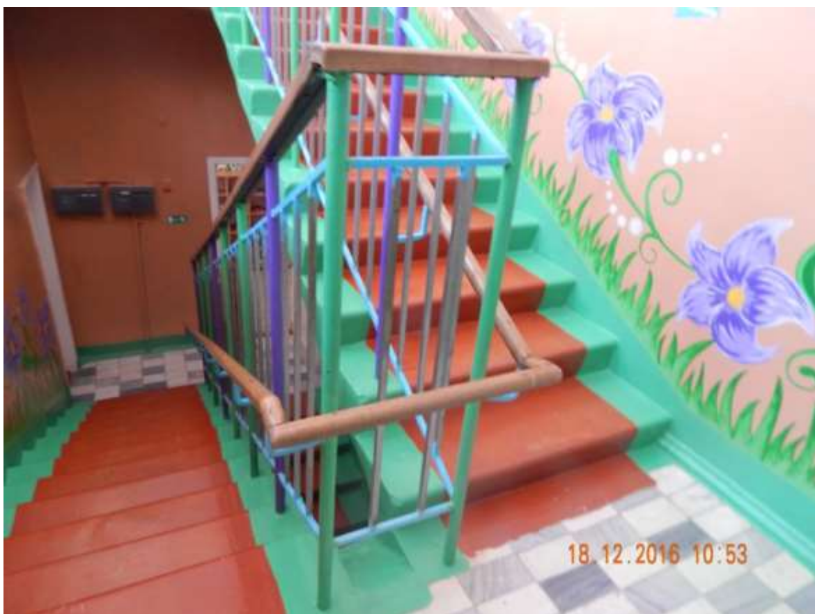
Фото № 8, п.3.3, лестница
