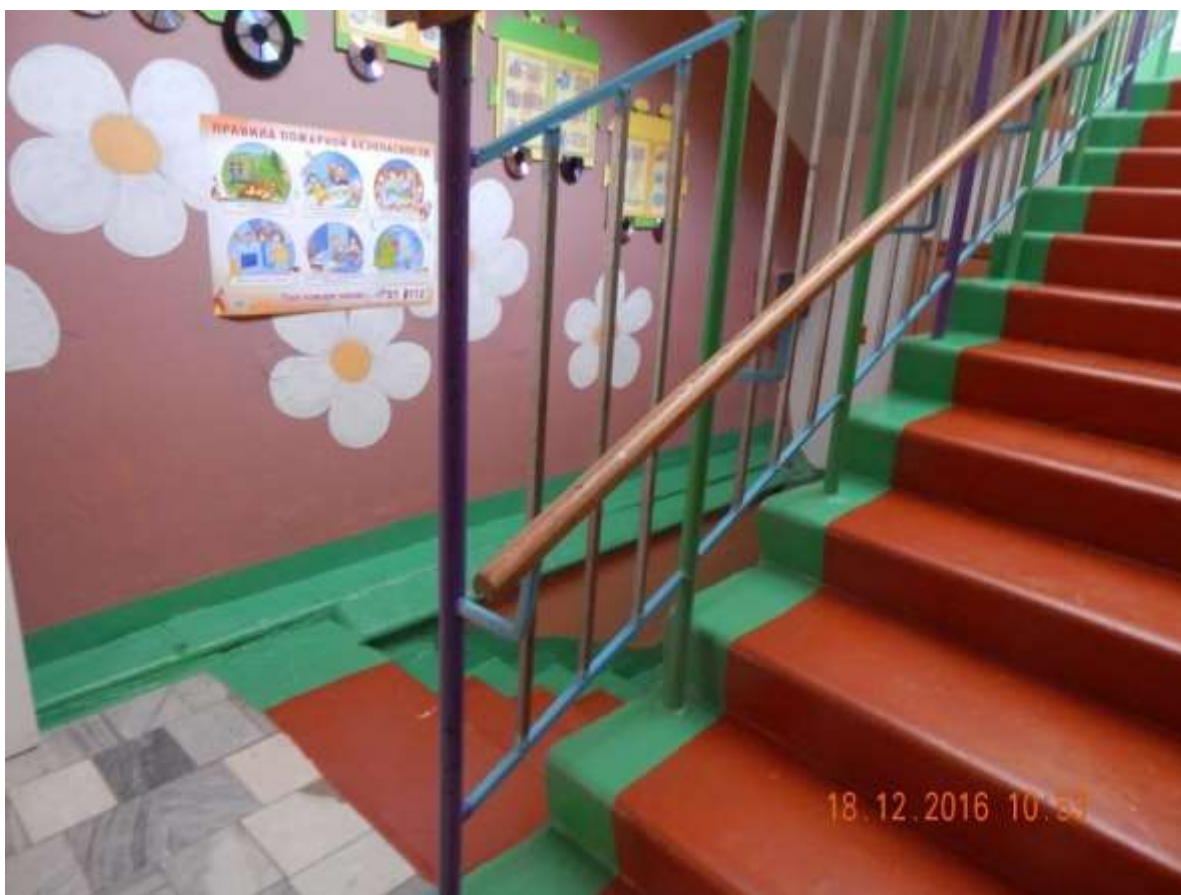
Фото № 6, п.3.1, холл с лестничным маршем
