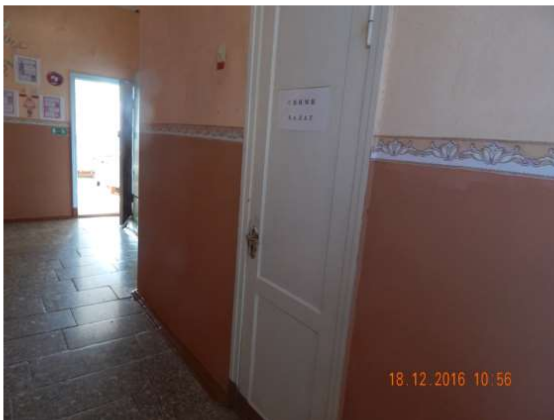
Фото № 19, п.5.1, вход в туалетную комнату
