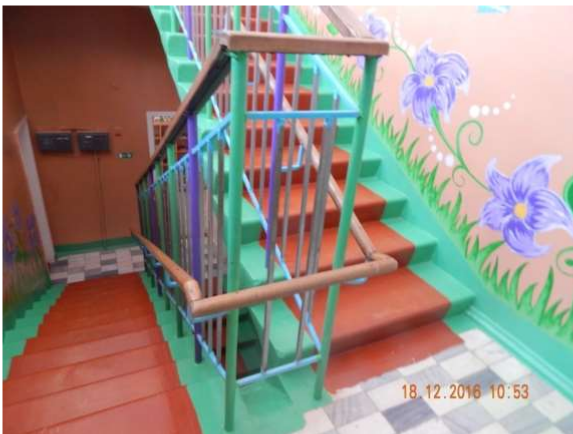
Фото № 7, п.3.3, лестница
