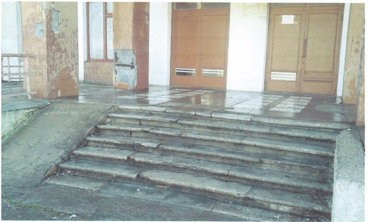
Фото № 6, 6 лестница наружная (наружный пандус)
