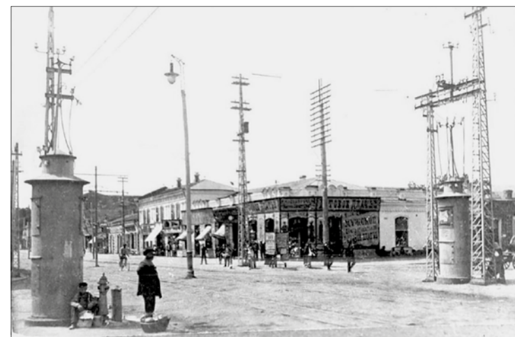
г. Екатеринодар: электросети и трансформаторные киоски. 1920 г.
