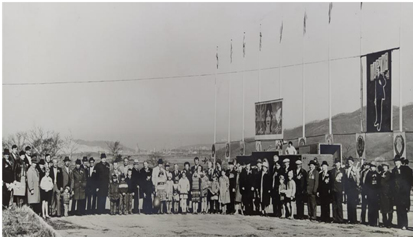
Фото12 – 13. 9 мая. Площадь Первостроителей
