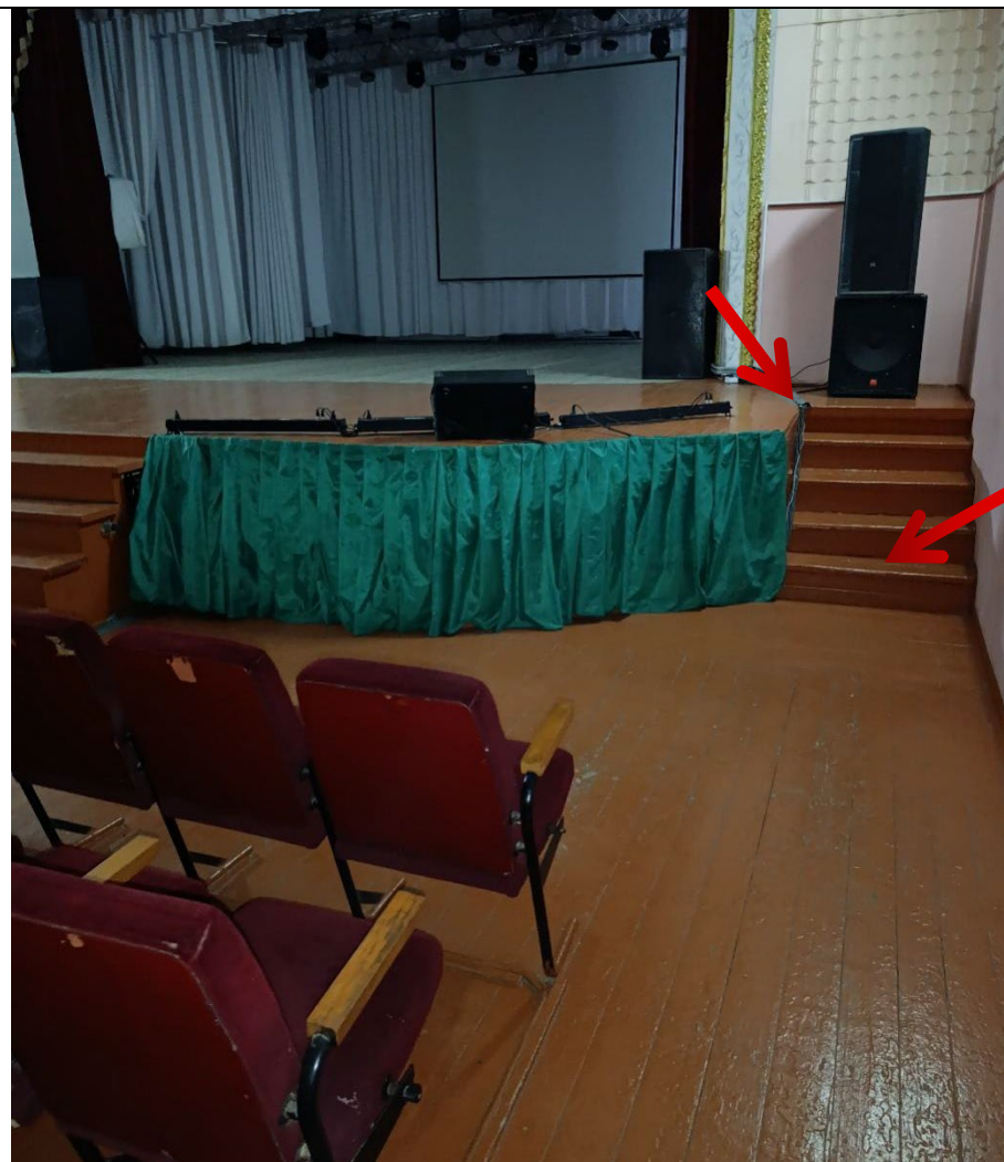
Фото № 12. Актный зал. На лестнице на сцену нет поручней. Краевые ступени контрастно не маркированы.
