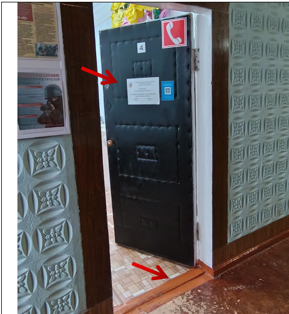
Фото № 11. Кабинет. Порог в дверном проеме. Табличка не тактильна.
