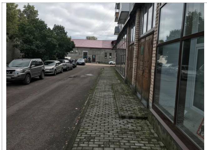
Фото №4 – Входная площадка
