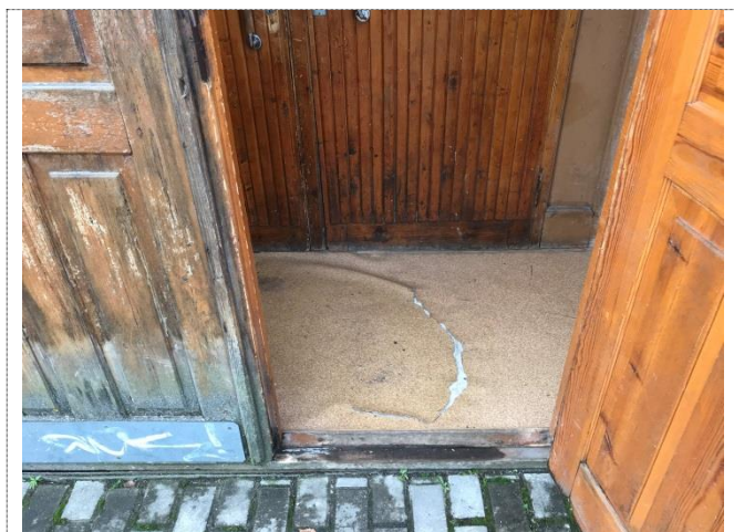
Фото №6 – Внешняя входная дверь
