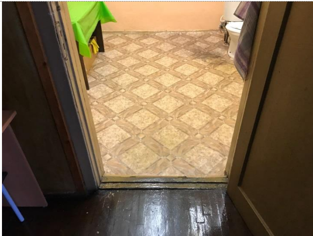
Фото №21 – Санитарно-гигиеническое помещение
