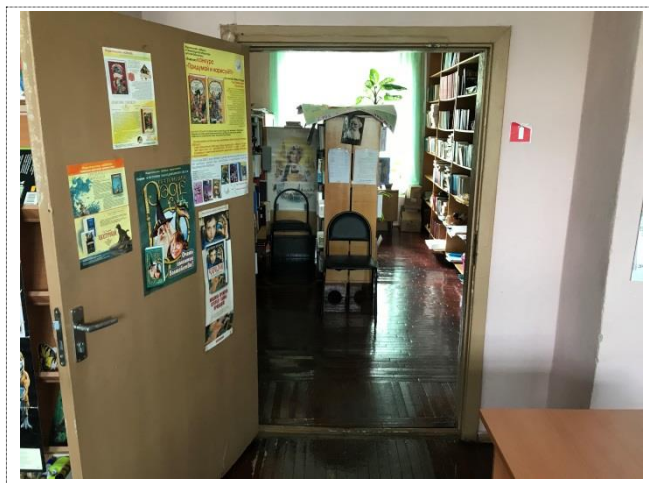
Фото №12 – Пути движения внутри здания (двери)
