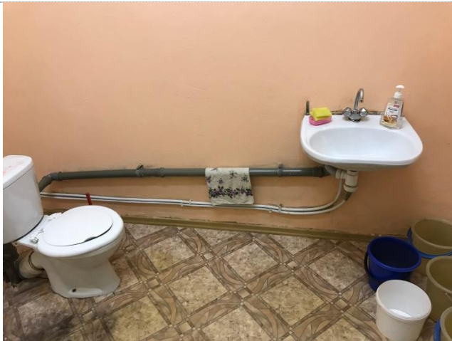
Фото №23 – Санитарно-гигиеническое помещение
