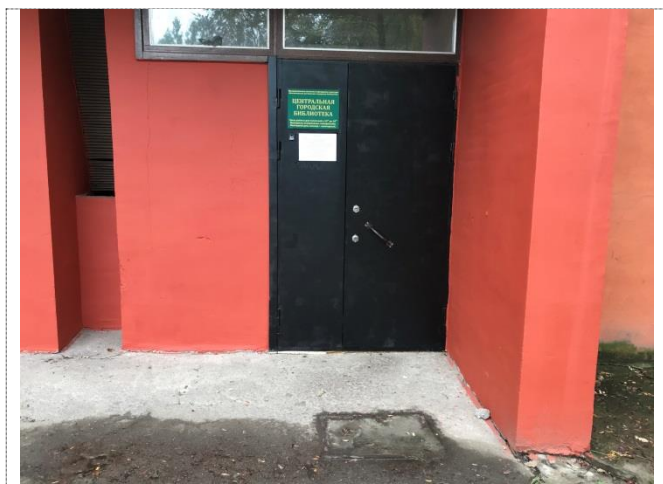
Фото №4 – Входная площадка
