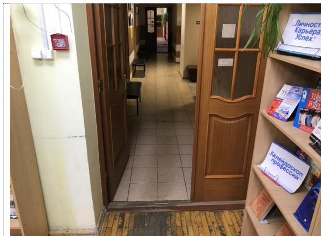
Фото №12 – Пути движения внутри здания (двери)
