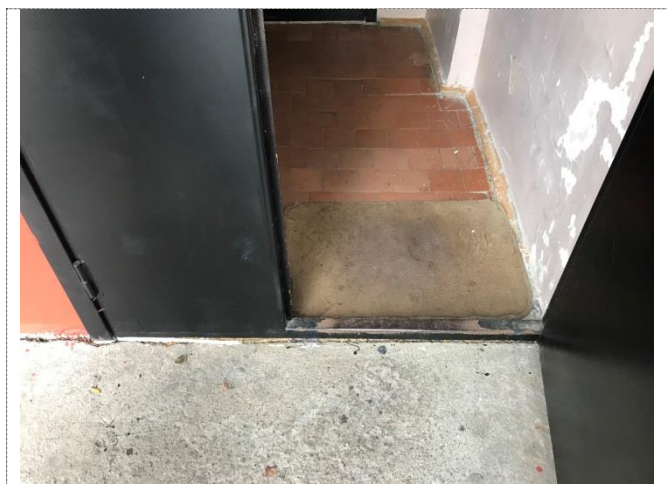
Фото №5 – Внешняя входная дверь
