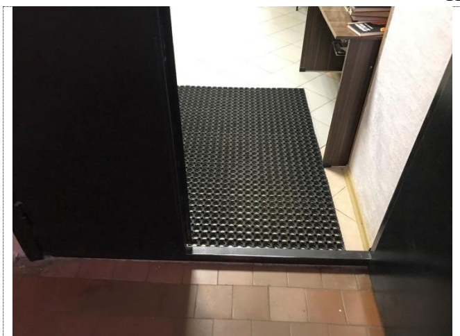
Фото №7 – Внутренняя входная дверь
