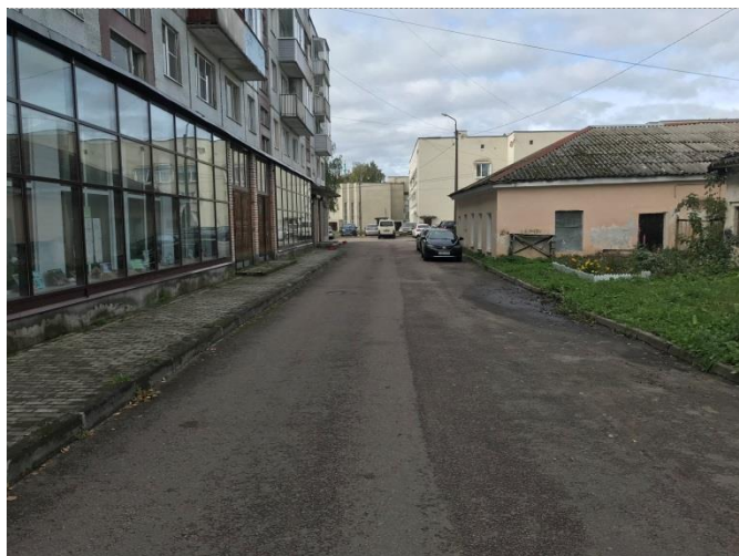
Фото №1 – Подходы к объекту
