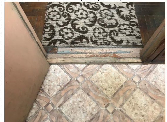
Фото №8 – Внутренняя входная дверь
