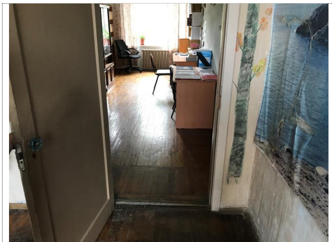
Фото №11 – Пути движения внутри здания (двери)
