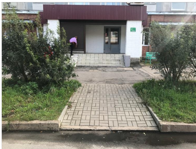
Фото №2 – Подходы к объекту. Главный вход.
