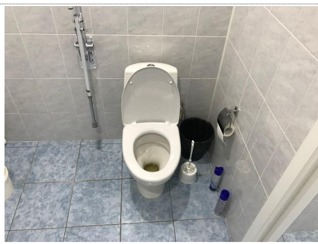
Фото №24 – Санитарно-гигиеническое помещение
