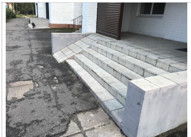
Фото №3 – Наружная лестница главного входа.
