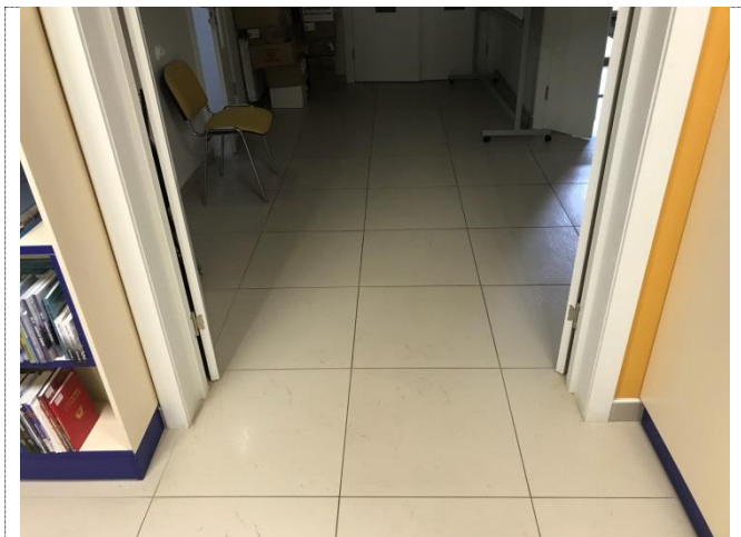
Фото №13 – Пути движения внутри здания (двери)
