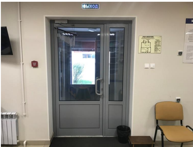
Фото №9 – Внутренняя входная дверь
