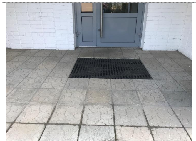
Фото №5 – Входная площадка
