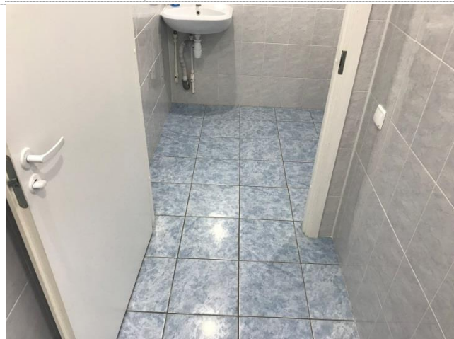
Фото №22 – Санитарно-гигиеническое помещение
