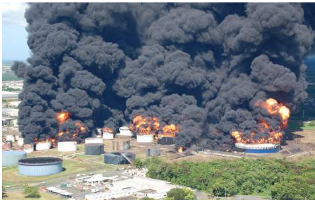
Рис. 38 — Авария на пожаровзрывоопасном объекте
