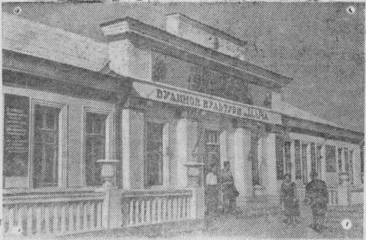
Херсонская область. Складовский район занял первое место в области по строительству колхозных клубов и Домов культуры.
