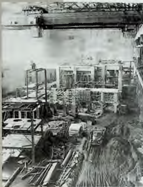
Монтаж турбины генератора
