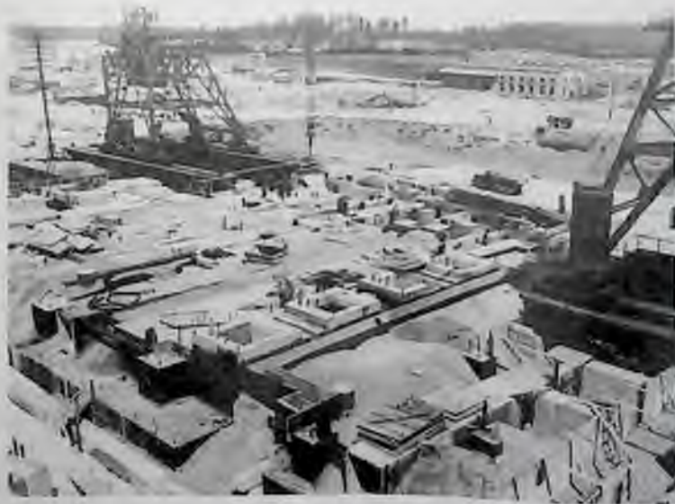
Возведение машинного зала 2-й очереди
