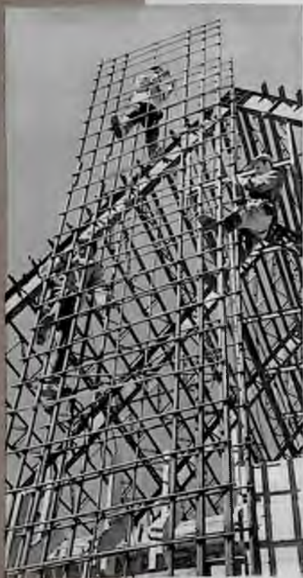
На строительстве асбообогатительной фабрики № 6
