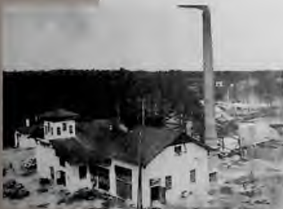
Электростанция бывшего рудника Жирарда. 1913 г.
