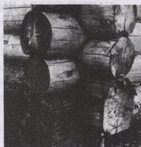
илл. 1/1 Угол сруба, рубленного в «обло», или «с остатком»: концы бревен выходят за пределы стены.
