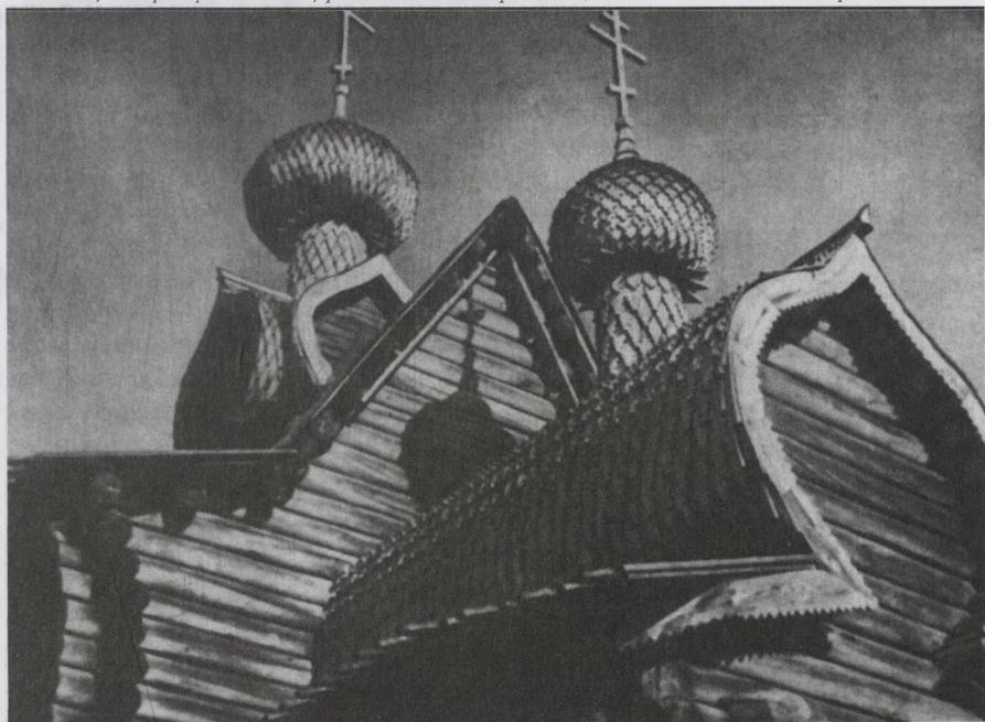
илл. 2/10 Преображенская церковь в селе Янидор. Главки, шейки главков и бочки покрыты лемехом.
