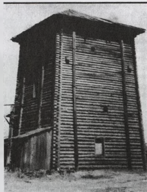
илл. 2/2 Расслопдьемная башня
