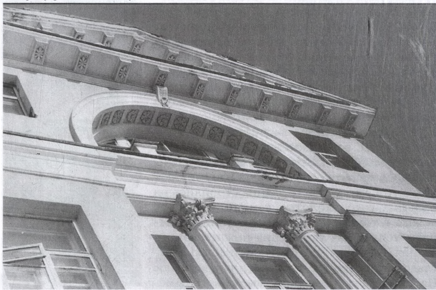
илл. 4/16 Здание Горной аптеки. Полукруглая ниша с прямоугольными углублениями-кессонами, которые украшены лепными розетками.
