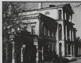
илл. 4/2 Дом Главного горного начальника: центральная часть не только выдается вперед и выше боковых на целый этаж, но и снабжена наибольшим количеством архитектурных элементов. Екатеринбург. Арх. М. Малахов
