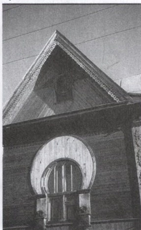
илл. 6/4 Окно с причудливым обрамлением. Фрагмент главного фасада жилого дома на ул. Толмачева в Екатеринбурге. 1912. Арх. И. Янковский
