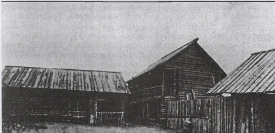
илл. 1/3 Изба с подклетом в деревне Пельым Чердынского района. Избу с подклетом (подсобным помещением, расположенным под жилой клетью) легко узнать: окна у нее расположены высоко над землей.
