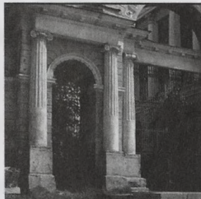
илл. 4/10 Здесь колонна каннелирована только на две трети сверху, низ ствола остается гладким. Ворота парадного подъезда дома Расторгуева-Харитонов.
