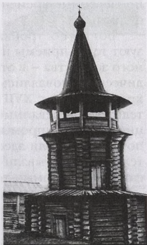
илл. 2/1 Колокольня в селе Верх-Язьва: два восьмиугольных сруба стоят один на другом, сверху – ярус звона с шатром на столбах. Конец XVII века
