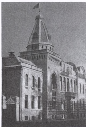
илл. 6/11 Особняк. 1907 г. Челябинск
