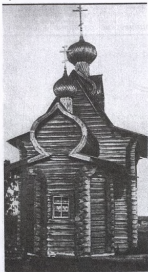
илл. 2/9 Преображенская церковь в селе Янидор, снабженная бочкообразной кровлей
