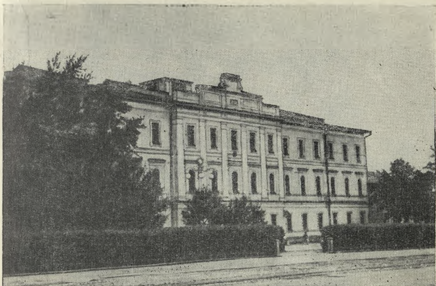
Здание Свердловской средней школы № 9 — памятник горнотехнического образования на Урале.
