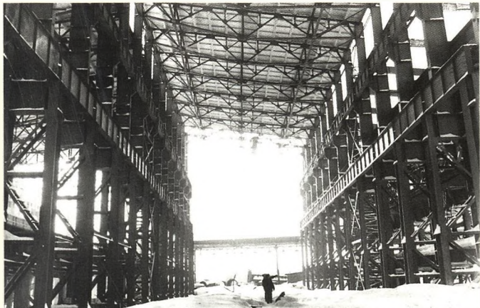
Строительство 7-ой секции. 1979 год
